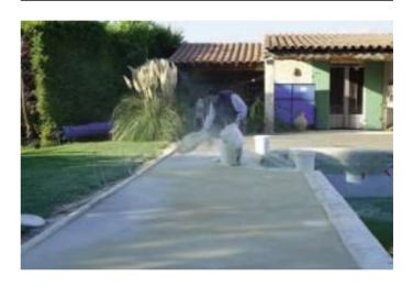
Après le lissage du béton, appliquer le **Composant N°1** (SOL DESIGN® DURCISSEUR) par saupoudrage manuel, à raison de 6 kg/m² minimum.
